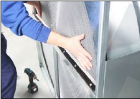
Kuva 2 Kallista roottoria varovasti. Varmista, että kiekon lamellit eivät vaurioitu.
