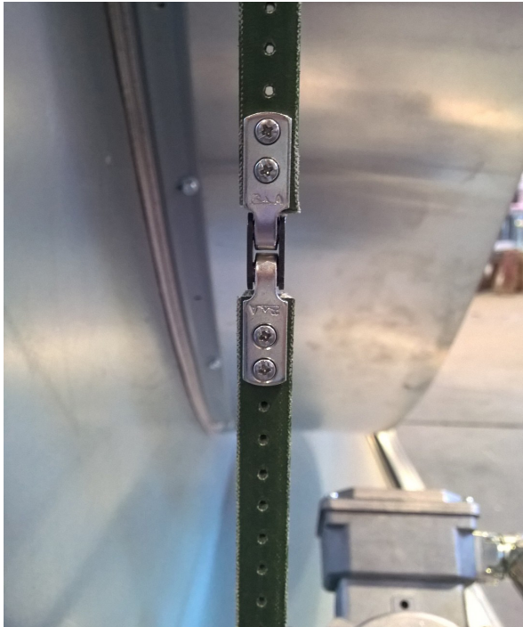
Åtdragning av rotorremmen
