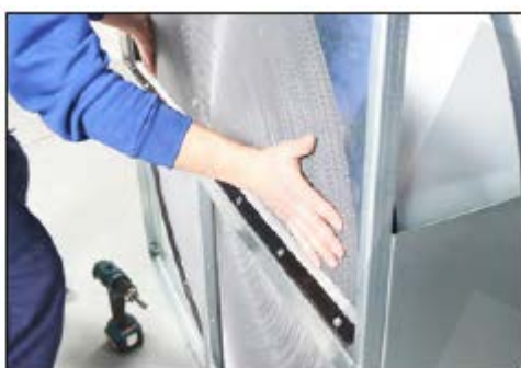
Изображение 2 Осторожно наклоните ротор. Убедитесь, что ламели диска не повреждены.
